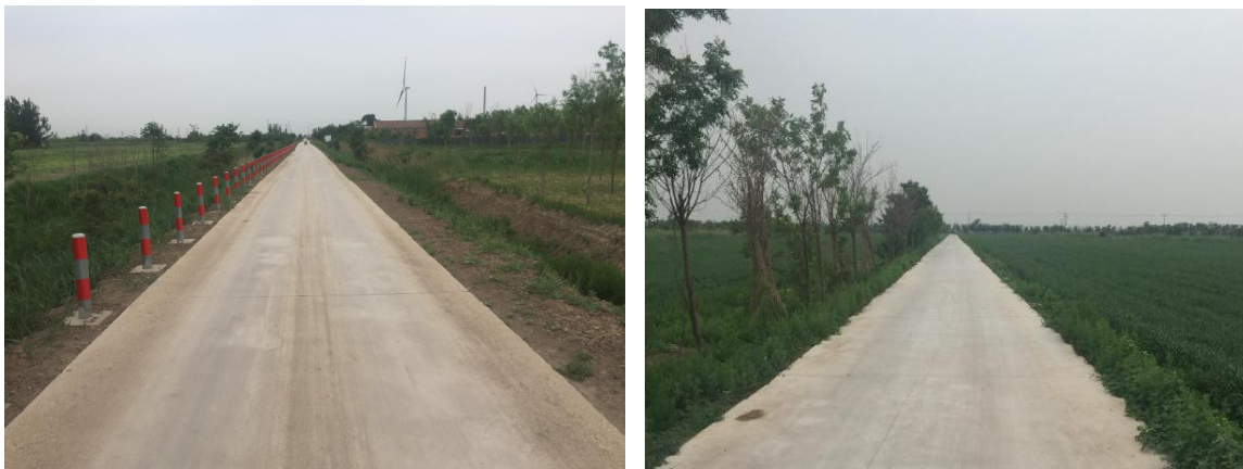
道路工程两侧临时堆土场植物措施完工照片
