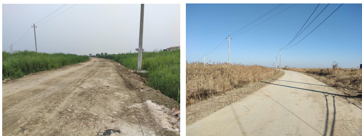
道路硬化完工前后对比（西杜庄村、中心台村）
