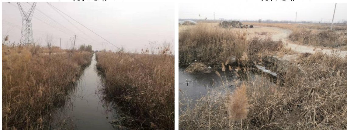
c) 现状生产渠照片
